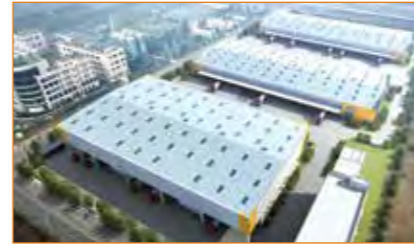
丰树成都中央厨房基地
