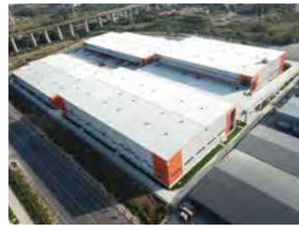
丰树成都青白江物流园项目顺利完工，是丰树在成都投资的第二个物流项目。
