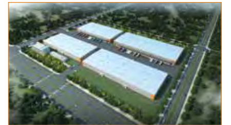
丰树长春经济技术开发区产业园
